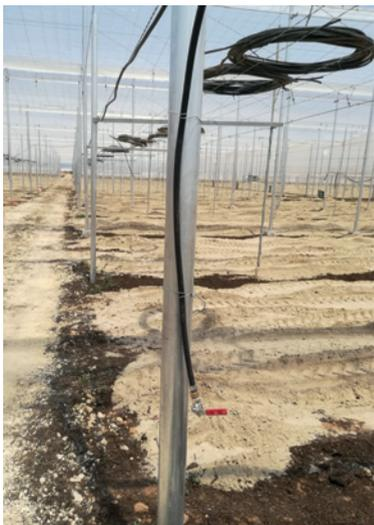
**Figura 3.** Tubería del invernadero y conexión a la tubería de la carretilla de pulverización.
